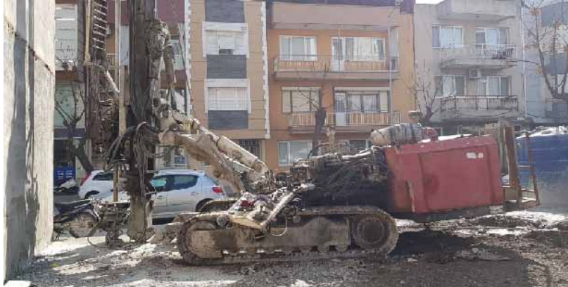
Resim-1: Zemin iyileştirme çalışmaları sırasında kullanılan zemin delme ve yüksek basınçlı çimento enjeksiyonu makinesi
